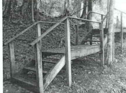
Elementos revisados, y registrados para un control específico.
